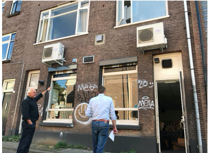
Hans inspecteert met een expert de ventilatie voorziening.
